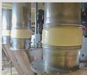
加圧ラインでの取付
