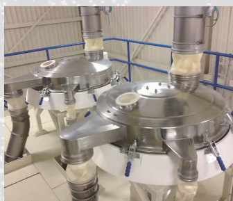
振動ふるい機の 投入口・排出口への取付
