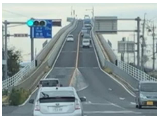
(島根県 松江市 : 江島大橋)
